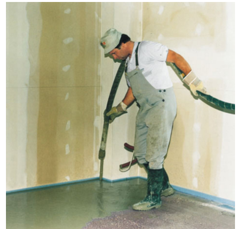
PCI Periplan CF 35 - en snabbtorkande avjämningsmassa för handspackling eller pumpning inomhus.
