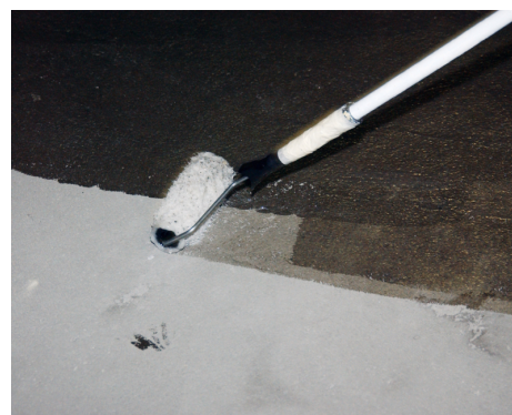
PCI Epoxigrund 390 - tätar porer, förhindrar luftbubblor från att krypa upp från underlaget till avjämningsmassan
