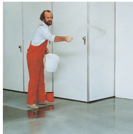
Den våta primern blir beströdd med kvartssand.
