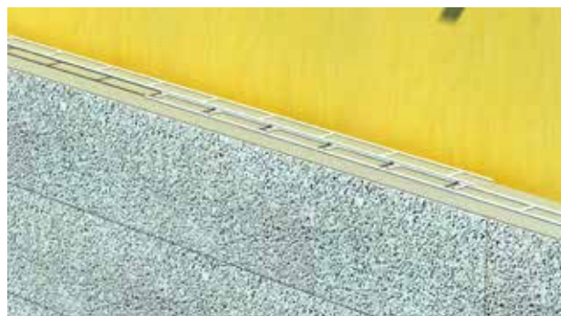
BILD 4. Eventuell armering läggs i bruket innan blocken för nästa skift läggs på och justeras.
