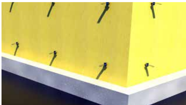
BILD 1. Montera kramlor ett par skift innan murning.
