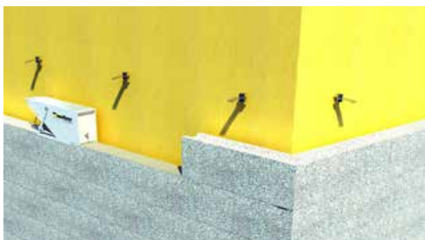
BILD 3. Blanda Flexoheft M2,5 enligt anvisningarna på säcken och håll det i murarlåden. Dra ut mursträngen och lägg ut blocken i förband.
