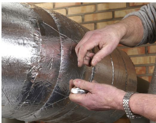
Spirallindning med förzinkad ståltråd som knopas minst en gång per enhet.
