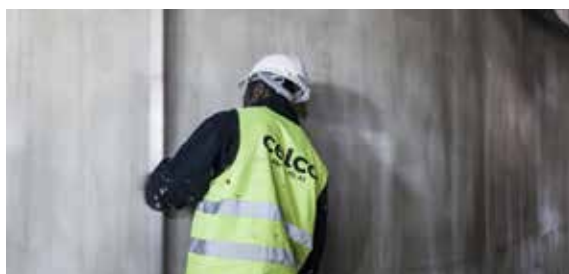
YTBEHANDLING AV INNERVÄGGAR SID. 10
