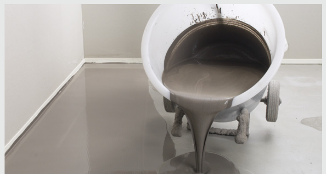
Spackelmasa hälls ut
