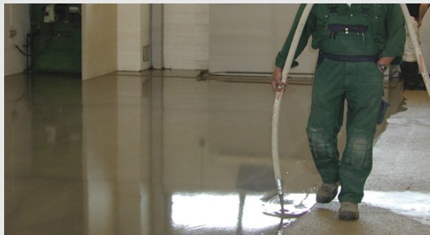
Planspackling med spackelpump
