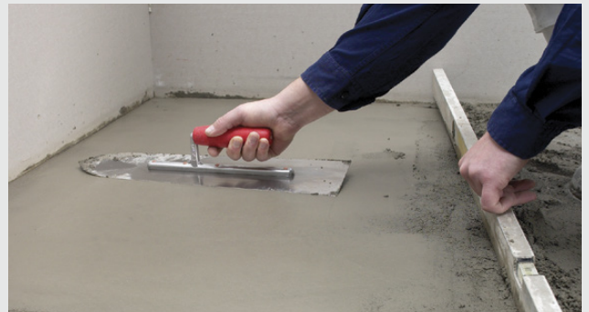
Cementbruk/slipsats glättas ut med spackel
