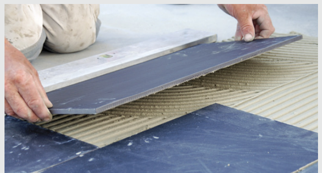
Montering av plattor
