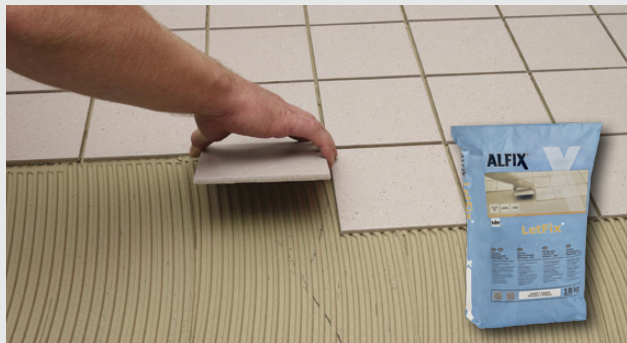
Plattläggning i Alfix fästmassor
