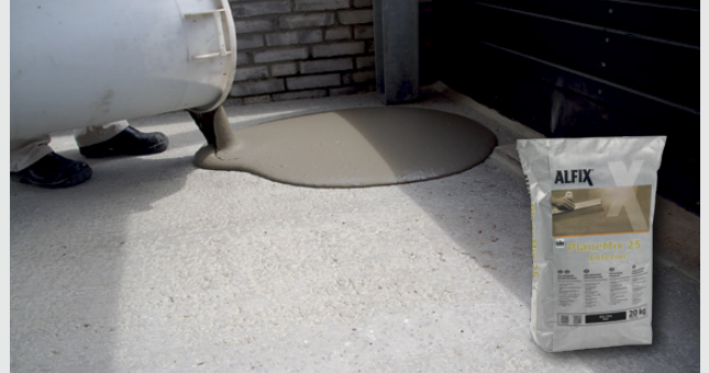
Självutjämnande spackelmassa hälls ut
