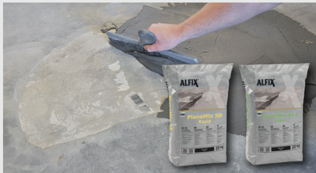
Sprickor och fördjupningar ifylls.
