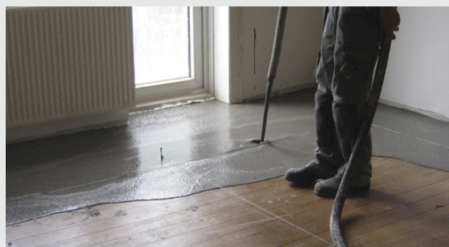
Spackling på träbjälklag
