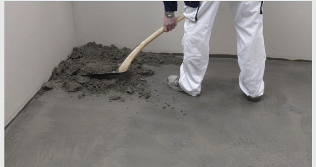
Cementbruk/slipsats fördelas jämnt
