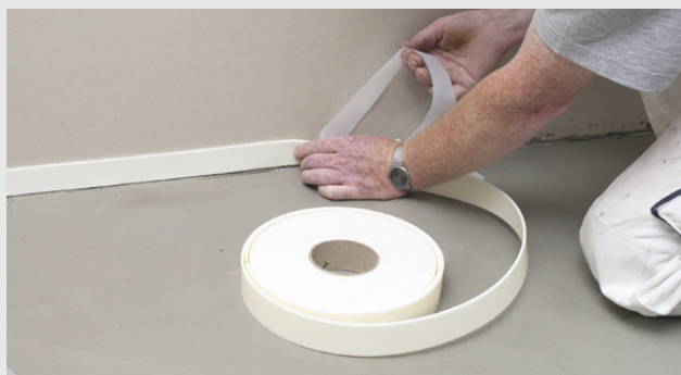
Montering av självhäftande väggkantband
