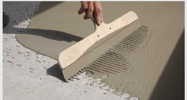
Fördelning med golvtandspackel
