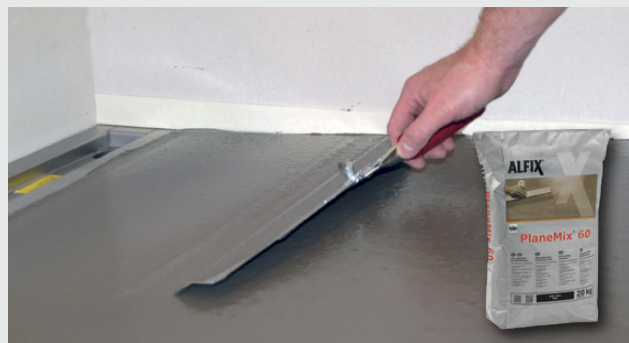
Fallupbyggnad vid designbrunn
