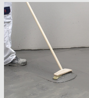
Slam/kvastning av golv
