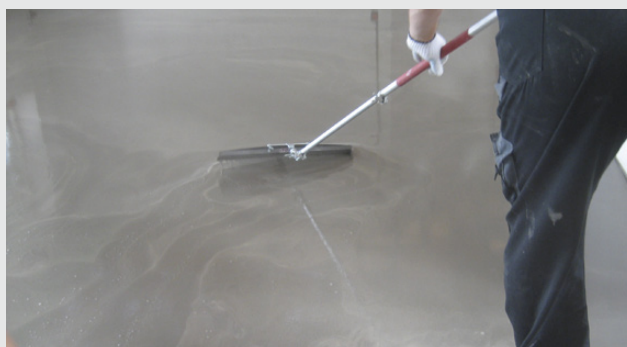
Fördelning av spackelmassan
