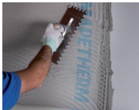
Applicering av förstärkt glättningsoch avjämningsskikt genom inbäddning av Mapetherm Net
