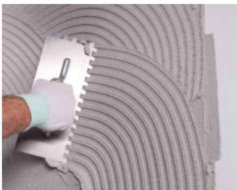
Läggning av det första skiktet glättningsmassa med Mapetherm AR1 GG
