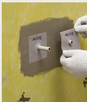
Montering av VT-Rörmanschetter
