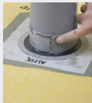
Förstärkning med Seal-Strip vid vattenbelastade rör
