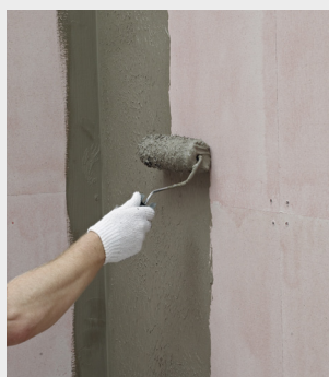
Påföring av tätningsmasse
