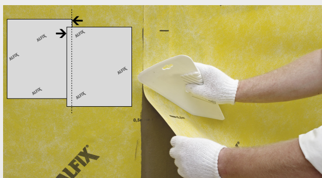
Montering av våd omlott vid skarv
