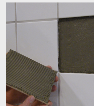
Tätningsmassan påförs underlaget och plattan monteras
