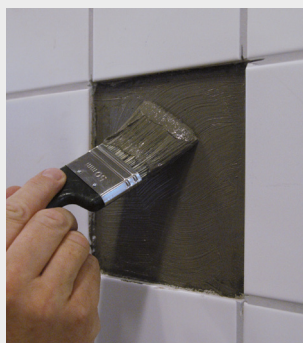
Tätningsmassan påförs underlaget och plattan monteras
