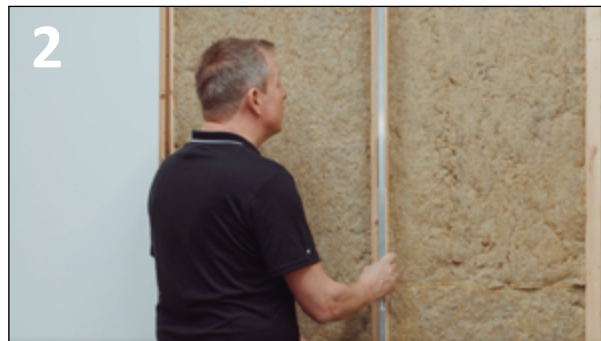
2 KOLLA ATT VÄGGEN ÄR RAK FÖRE MONTERING
