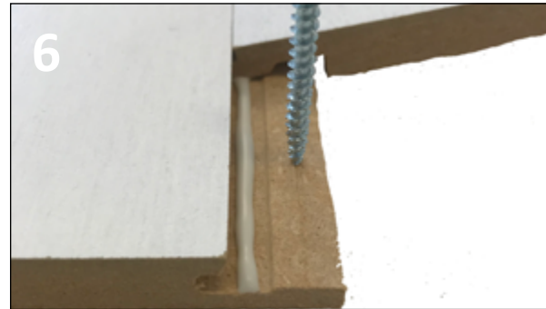
6 CA. 1 MM TJOCK LIMSTRÄNG LÄNGST HELA PROFILEN SKRUV ELLER KLAMMRA I SPONTEN.
