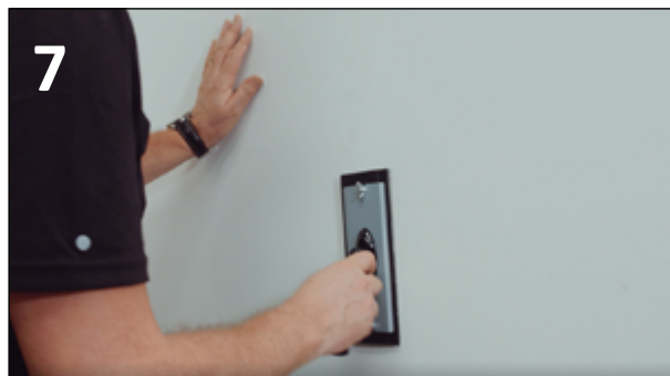
7 SLIPA LÄTT ÖVER FOGEN MED SLIPPAPPER CA. 120
