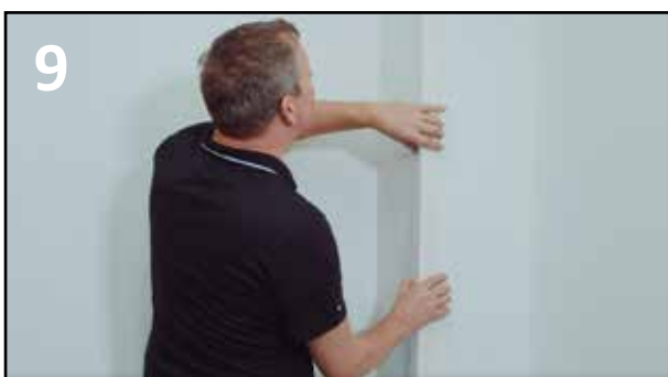
9 ANVÄND FLEXILIST ELLER SPACKLA YTTRE HÖRN
