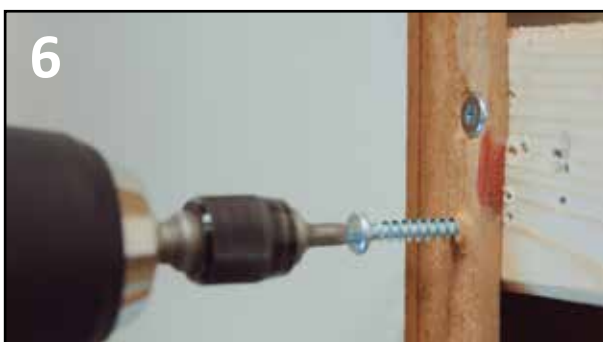
6 DUBBEL INFÄSTNING PÅ HORISONTELL UTLÄKTNING
