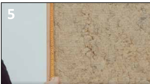
5 SKRUVAVSTÅND PÅ REGEL MED CC AVSTÅND 150-200 MM. HUNTONITSKRUV 4,2X35 MM ELLER LAMINATSKRUV MFT 3,9X35 MM ALT. KLAMMER MIN 30 MM, RYGG 10 MM
