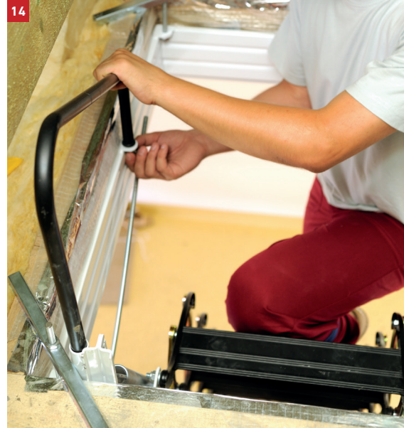
14 Testing the springs and mounting the optional handrail - Fjædre afprøves og evt. håndliste monteres - Kontrollera fjädringen och montera eventuell ledstång - Fjærene prøves og ev. håndlist monteres
