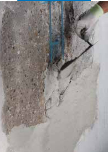
Applicering av Planitop Smooth & Repair med spackel
