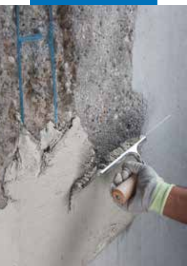
Applicering av Planitop Smooth & Repair med spatel
