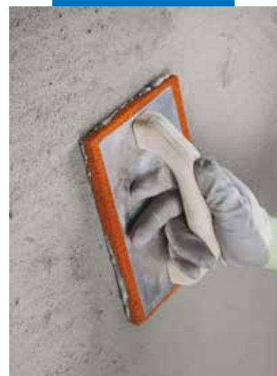
Stampning av Planitop Smooth & Repair
