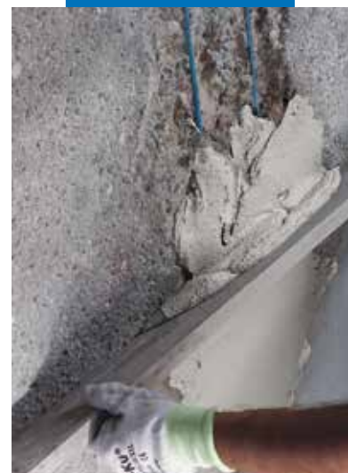
Glättning av Planitop Smooth & Repair med riktskena
