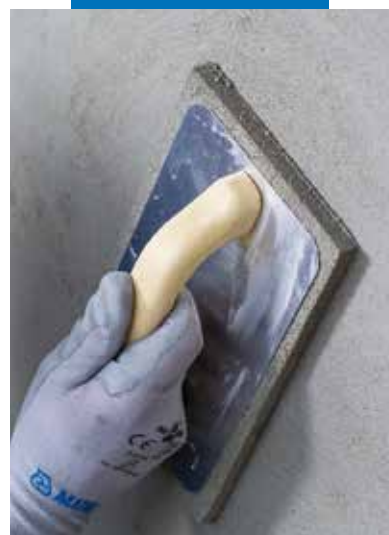
Putsning av yta med Planitop Smooth & Repair R4
