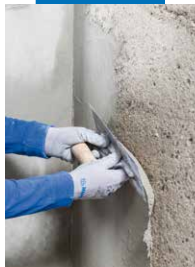
Applicering av Planitop Smooth & Repair R4 med en spackelkniv
