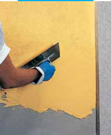
Applicering av Silexcolor Tonachino med spackel
