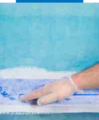
installation Mapei ST T tband med anv ndning Mapegum WPS,  verg ng golv/ v gg
