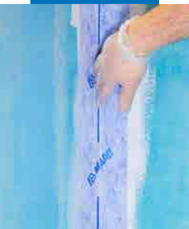
installation Mapei ST T tband med anv ndning Mapegum WPS, v gg
