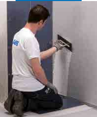
Applicering av fästmassa
