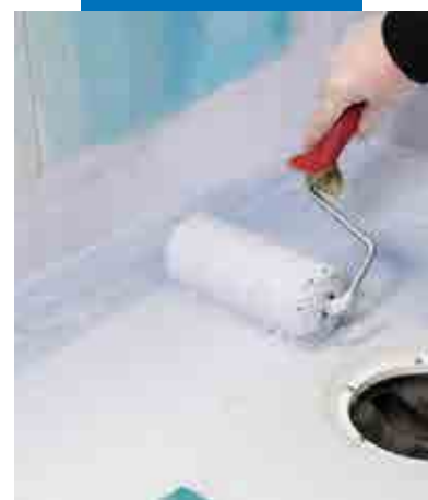
Applicering av Mapegum WPS med till exempel roller
