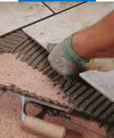
Montering av granitkeramik på befintlig utvändigt vägg av terrassplattor
