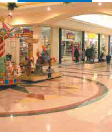
Ett exempel på installation av keramiska plattor - Zanchetta shoppingcenter - Treviso (Italien)
