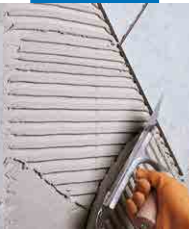
Montering av granitkeramik på lättbetongvägg
