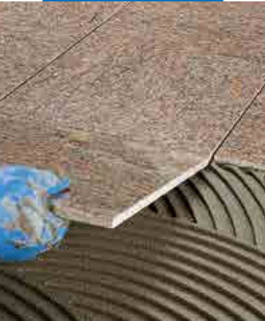
Installation av förpolerad marmor på golv
