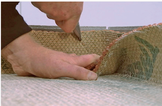
Skär till hörn och vinkla mattan upp mot väggen
