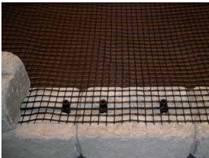
Bilde 4. Montering av Bender Geonät på första skiftet. Sätt fast nätet över låspluggarna. Låt pluggarna sticka upp ur tredje raden på nätet så att så mycket nät som möjligt ligger mellan stenlagren utan att sticka ut. Då sitter nätet bäst.
