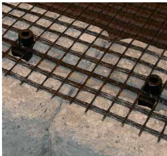
Bilde 4. Montering av Bender Geonät på första skiftet. Sätt fast nätet över låspluggarna. Låt pluggarna sticka upp ur tredje raden på nätet så att så mycket nät som möjligt ligger mellan stenlagren utan att sticka ut. Då sitter nätet bäst.
