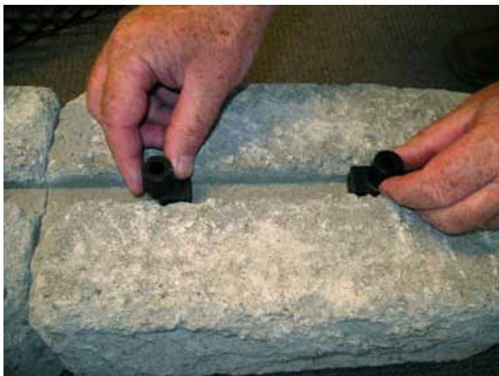
Bilde 2. Montering av Bender Låsplugg för vertikal mur. Montera två st Bender Låsplugg per block.
