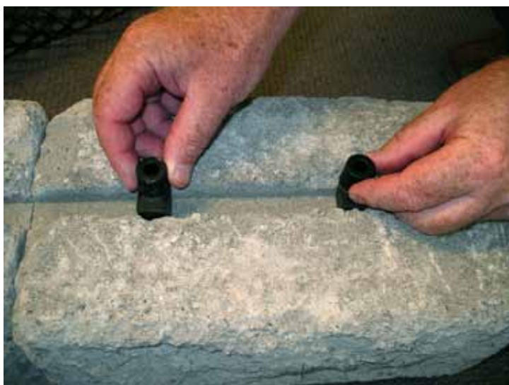
Bilde 3. Montering av Bender Låsplugg i för lutande mur. Montera två st Bender Låsplugg per block.
