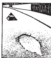
Beläggningsskada
