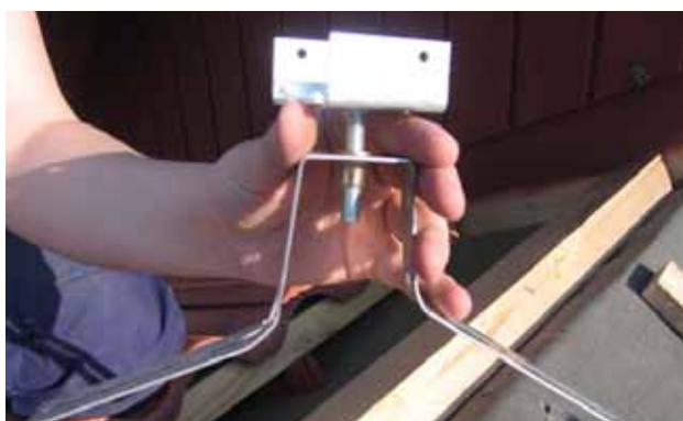
Monteringsbild 2. Böcka U-benen så du erhåller rätt höjd, finjustering kan du göra senare. Tänk på att U-benen skall ligga ovan bärläkt på lätt undertak och ovan ströläkt vid traditionellt tak (råspont).
