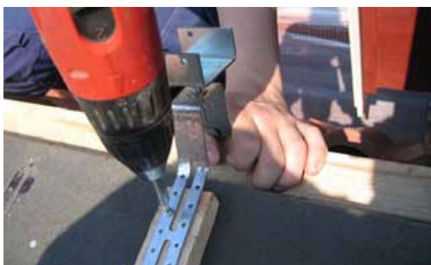
Monteringsbild 3. Skruva fast en nockhållare i vardera ändan av nockbrädan och justera in i rätt höjd.
