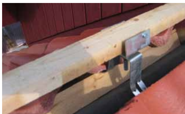
Monteringsbild 6. Lägg dit nockregeln/läkten och fäst den. Lägg sedan dit nocktätningen. Till sist, lägg på nockpannorna. Du har nu fått en optimal, ventilerad och rak nock.
