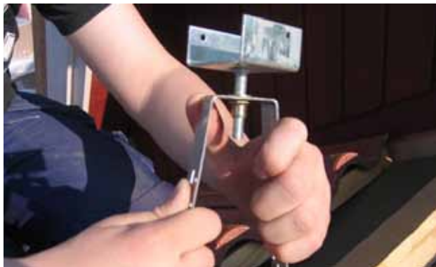
Monteringsbild 1. Böcka U-benen till lämplig vinkel, det gör du lätt för hand. Ställ förskruvningen i mittläge.
