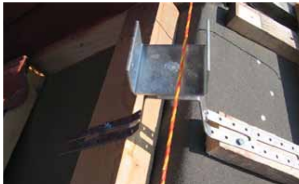
Monteringsbild 4. Montera ett snöre i centrum av de båda nockhållarna som placerats på taket. Montera dit resterande nockhållare som nu får rätt höjd och även görnocken absolut rak. Bilden visar höger sida råspontsmontage, vänster sida lätt undertak.
