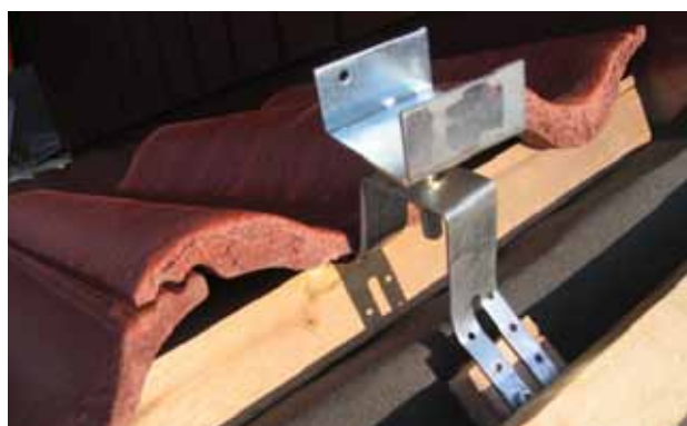
Monteringsbild 5. Lägg dit takpannorna och passa in dessa så de ligger bra, fäst pannorna.
